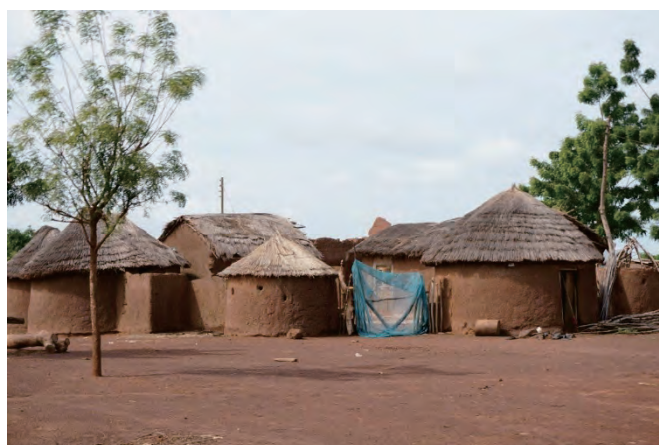
写真3：ガーナの農村部。通称「きのこハウス」は藁と泥と木材からできている。
